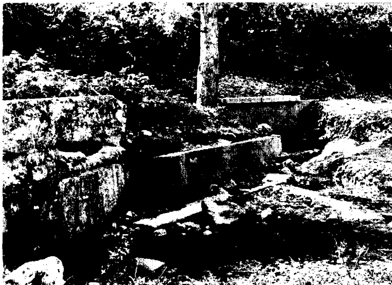
Сл. 2. — Руинирана стара каптажа на сифонском извирању Белопаланачке Бањице и новоподигнута чесма. У предњем плану отоке обе каптаже. (Снимљено: 4. X 1970.).
