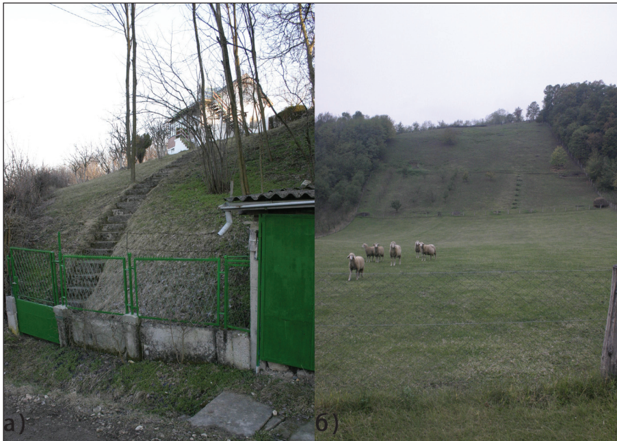
Скица 44. Клизни одсек; а) Белички, б) Буковичко-рибнички клизни појас Figure 44. Landslide scar: a) Belica sliding zone, b) Bukovica-Ribnica sliding zone
