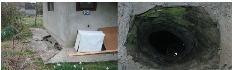
Скица 7. Стаза одвојена од зграде (а) и елипсasti обим бунара (б). Клизиште КБ 176 Figure 7. The path separated from a building (a) and elliptical outline of a well (b). Landslides КБ 176 9
