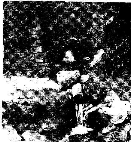
Фот. 4. Изливање термалне воде из бушотине на десној страни Бањске реке на грлу усахлог извора „Светиња“ у Страгарској Бањи. На оквиру бушотине сруштирајуће изливање (Снимљено: 23. IX 1975., клише М. Костић)
