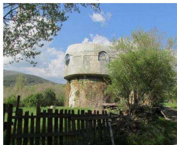
Слика 72г: Објект на излезот од селото
