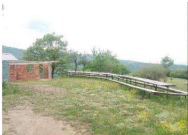
Слика 5а: Простор со верски објект во изградба
