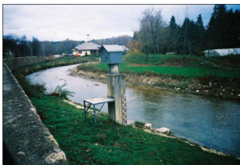
Сл. 23. Водомерна станица на реци Скрапеж у Косјерићу (фото: М. Миливојевић) Fig. 23. Hydro-measurement station on the Skrapež River in Kosjerić (photo: M. Milivojević)
